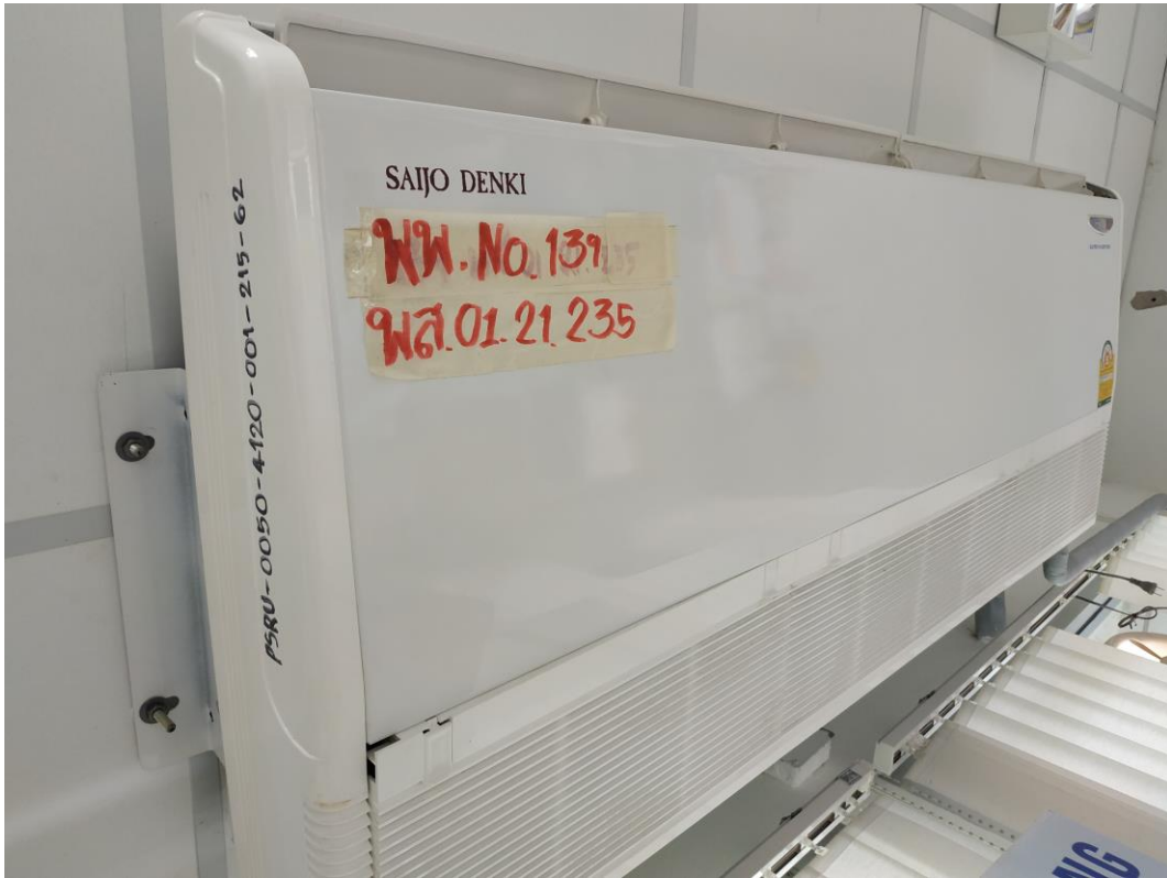
เครื่องปรับอากาศ ขนาด 36000 BTU PSRU-0050-4120-001-215-62 ห้อง กอ.206
